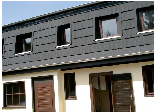
Dieses patentierte Leichtdach hat Bernd Weinzierl bei der Transport-Firma von Holger Philipp in Radebeul installiert. Vier Aufträge vergab er schon an den Handwerker aus der Nähe von Zwickau. Preis, Service, Ausführung – für Philipp passte alles.
