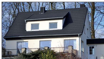
Dieses Haus in Thürmsdorf bei Königstein hat Dachdecker Bernd Weinzierl mit einem sturmsicheren Leichtdach gedeckt. Die zufriedenen Eigentümer konnten aus diversen Farb-, Material- und Design-Varianten wählen.
